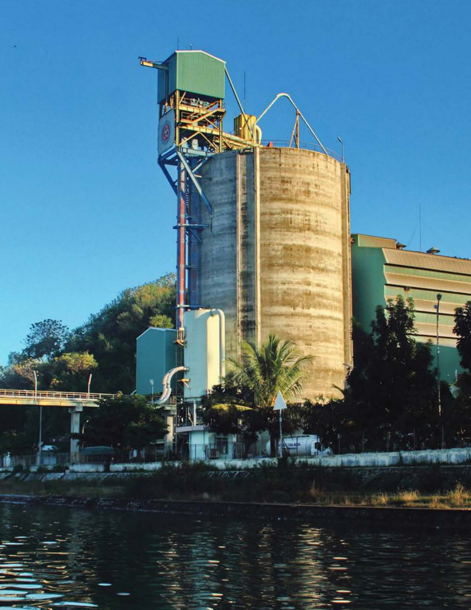
TERMINAL LEMBAR, LOMBOK BARAT, NUSA TENGGARA BARAT LEMBAR TERMINAL, WEST LOMBOK, WEST NUSA TENGGARA
